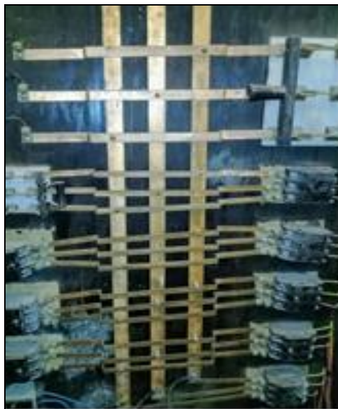
Figura 10 – Quadro Geral de energia elétrica
