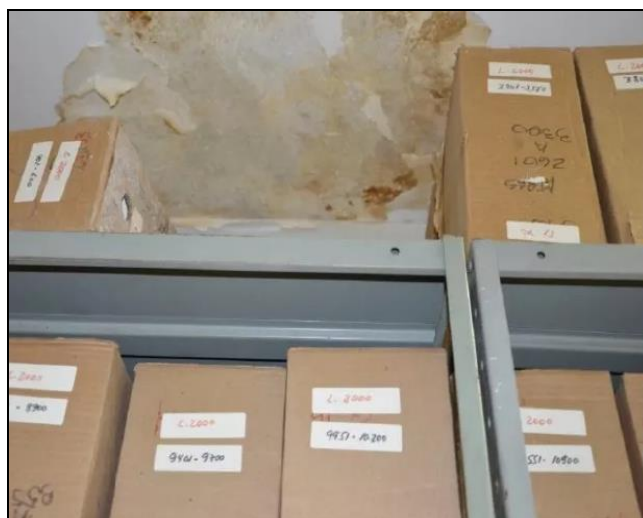
Figura 16 – Infiltração em sala de arquivos
